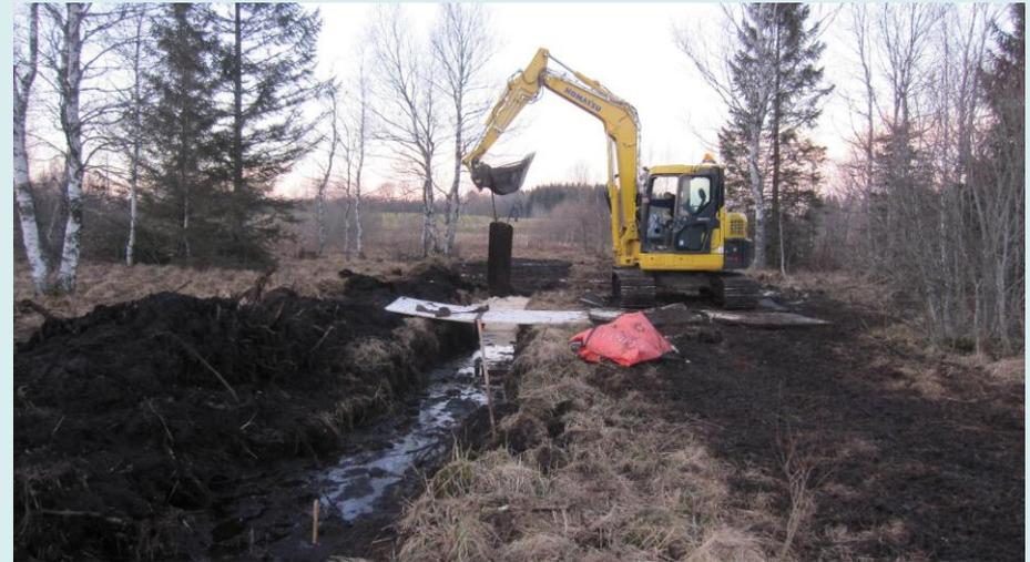
4- Pose des panneaux, remplissage à la sciure, 16 couverture de la tourbe issue du curage
