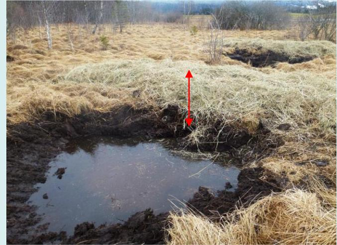
2- Palissade couverte de tourbe et paillée. La tourbe est prélevée immédiatement en amont de l'ouvrage, la gouille créée se remplit d'eau rapidement.
