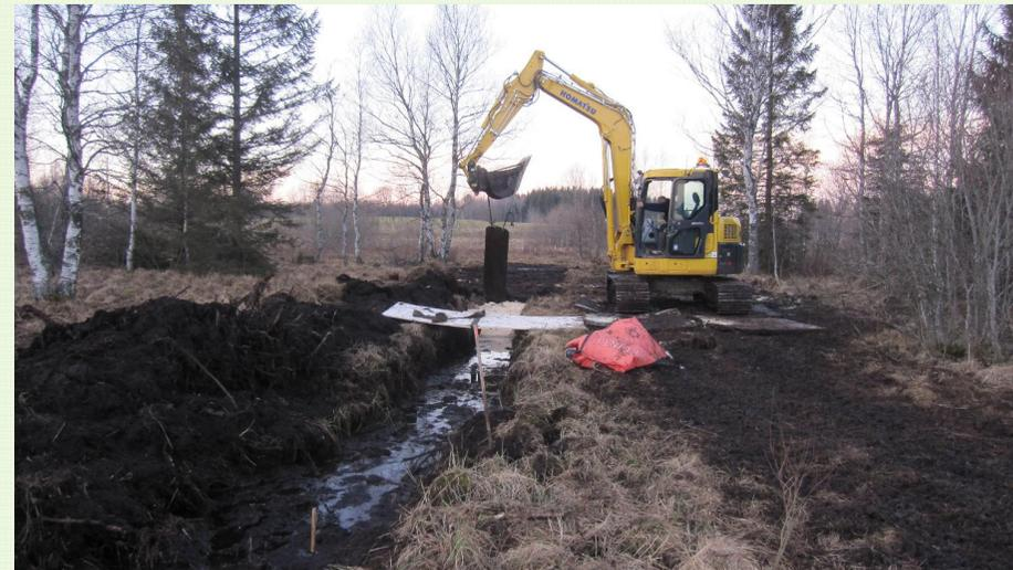
4- Pose des panneaux, remplissage à la sciure, couverture de la tourbe issue du curage 10
