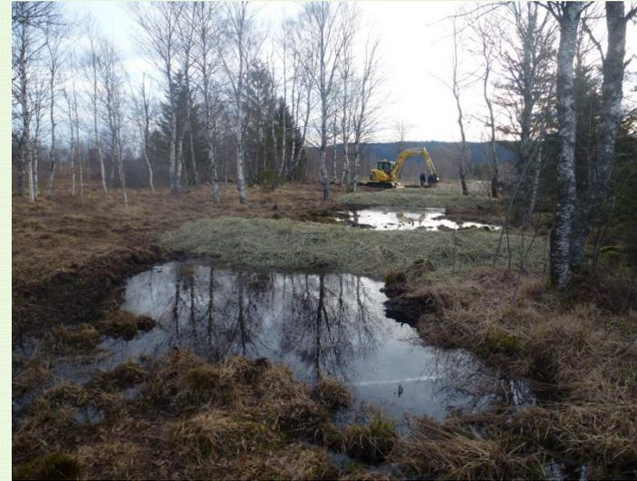
2- Vue des 3 palissades amont, 4<sup>ème</sup> en construction, étalement de la lame d'eau bloquée par les ouvrages sur la tourbière .
