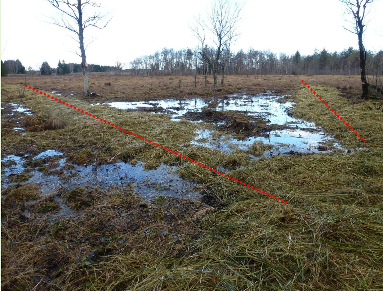
Partie amont : les 2 bras du fossés sont totalement neutralisés, la remontée d'eau est quasiment immédiate, l'eau s'étale sur le terrain.
